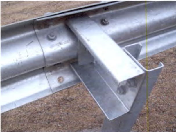
Foto 3: Puente La Corrida Faltan pernos en defensas camineras
