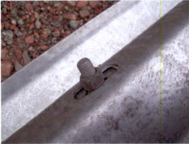
Foto 7: Puente La Subida Faltan golillas en defensas camineras
