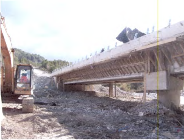
Foto 13: Puente El Correa Cauce del río muy embancado
