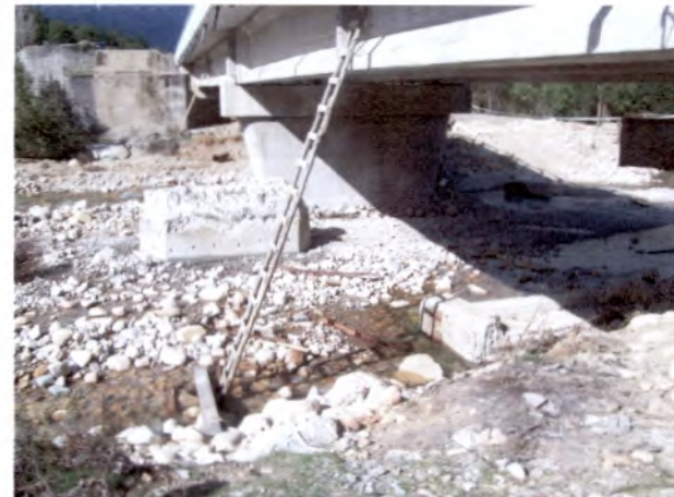
Foto 12: Puente El Salto Hormigones antiguos en cauce del río
