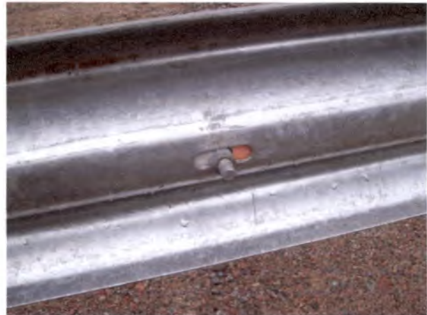
Foto 4: Puente La Corrida Faltan golillas en defensas camineras
