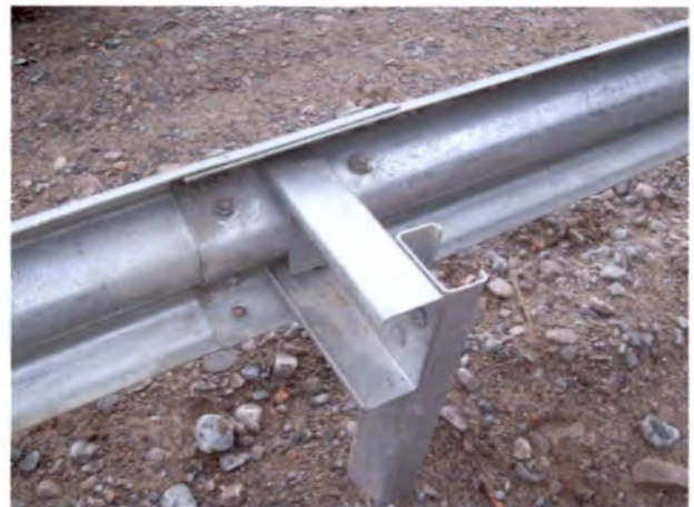
Foto 6: Puente La Subida Faltan pernos en defensas camineras
