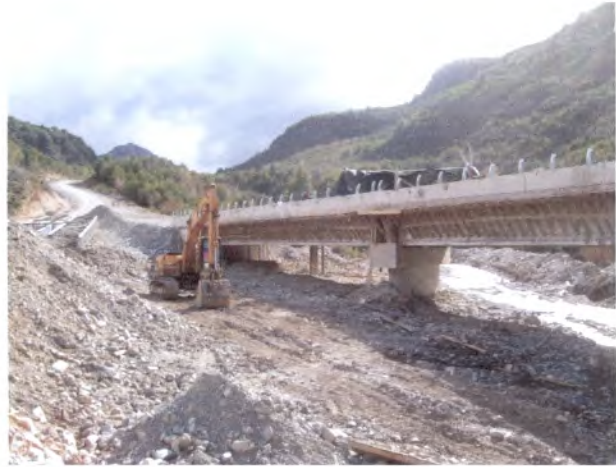
Foto 14: Puente El Correa Cauce del río muy embancado
