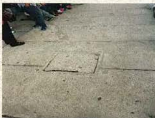
Fotografías N° s. 24 y 25: Tapa de cámara de desagüe rota, ubicada donde los usuarios de micros y buses circulan. (Ubicación cajero automático).
