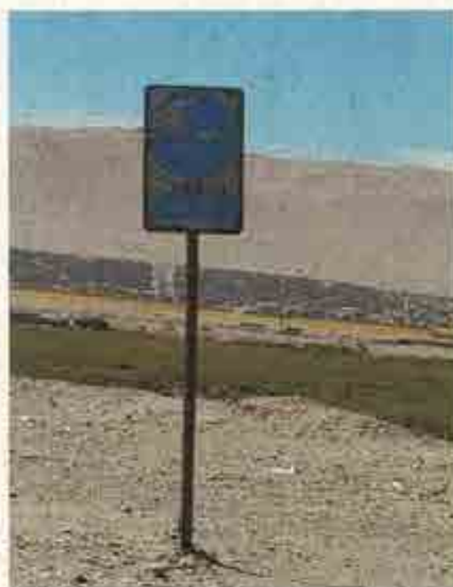
Fotografía N° 8: Señalética de vía de evacuación oxidada. Camino al humedal desembocadura del río Lluta.
