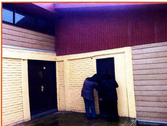
Fotografía N°1: Bodega Gobernación Provincial de Valdivia.
