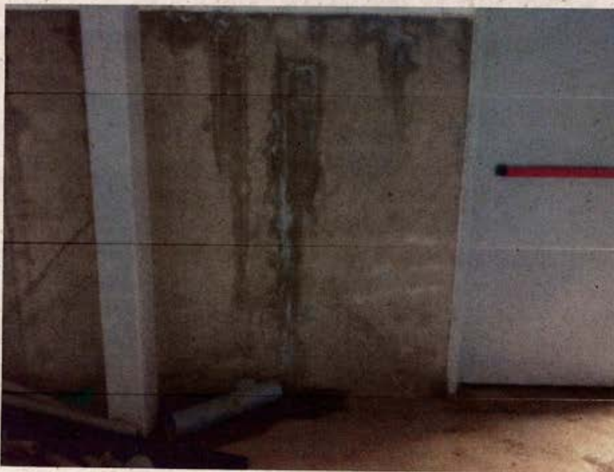
Fotografía N° 1: Filtraciones muro de contención.
