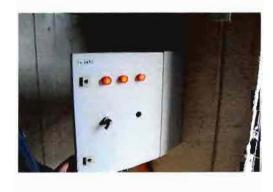
Foto 4.- Falta identificación de circuitos y diagramas.
