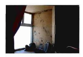
Foto 3.9.- Ventanas no selladas correctamente, traspaso de humedad.
