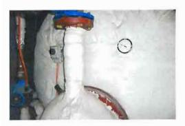
Foto 3.6.- Boiler instalado con elementos reutilizados existentes.
