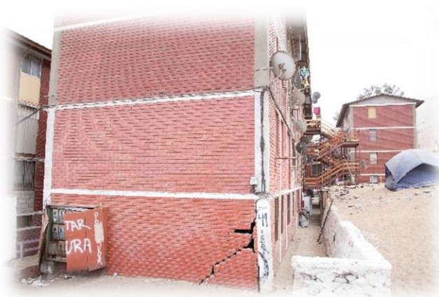
Imagen 2. Block dañado por los terremotos del 1 y 2 de abril en el sector Las Dunas, Iquique.
